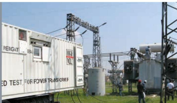
Die mobile Niederfrequenz-Trocknungsanlage von HIGHVOLT und HEDRICH stellt eine komplette Neuentwicklung dar. Durch die kompakte Bauweise kann sie flexibel an nahezu jedem Ort auf der Welt eingesetzt werden und gewährleistet damit eine wesentliche Zeit- und Kostenersparnis. Sie verfügt darüber hinaus über alle Vorteile der bewährten stationären Anlagen. Zusätzlich können auch bestehende Anlagen mit modernster LFH-Technologie nachgerüstet werden.
